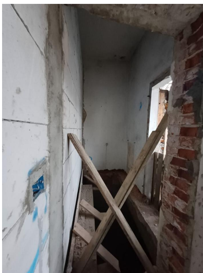
PARTICOLARE DEL TAGLIO DEL SOLAIO PER INSERIMENTO SCALA
